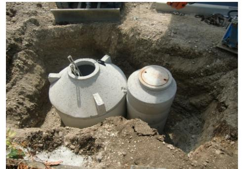
ist vorbildlich. Im Neubaugebiet Birkenstraße dienen wegen der Bodenverhältnisse Rigolen der gedrosselten Abgabe des Regenwassers an den Regenwasserkanal. Bei schlecht durchlässigem Bodenmaterial können sie auch als Zwischenspeicher fungieren und das zugeführte Regenwasser somit langsamer abgeben, was das öffentliche Regenwassernetz ebenfalls entlastet.
