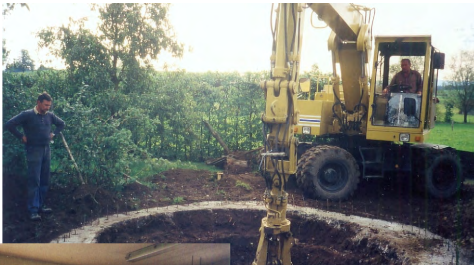
Aushubarbeiten für die 30 Tonnen Fundamente der Sternwarte durch Helmut Biller und Andreas Gättinger
