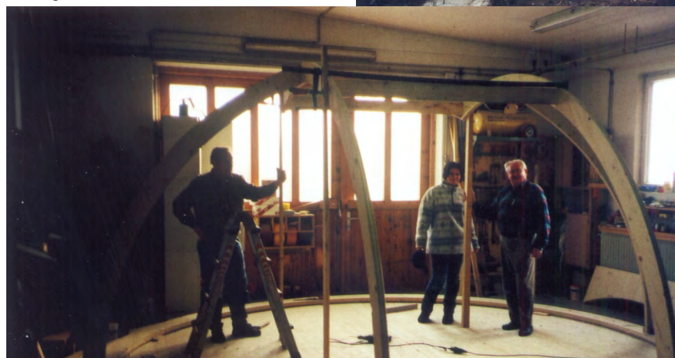
Bau der Kuppel bei der Schreinerei Rudi Gättinger
