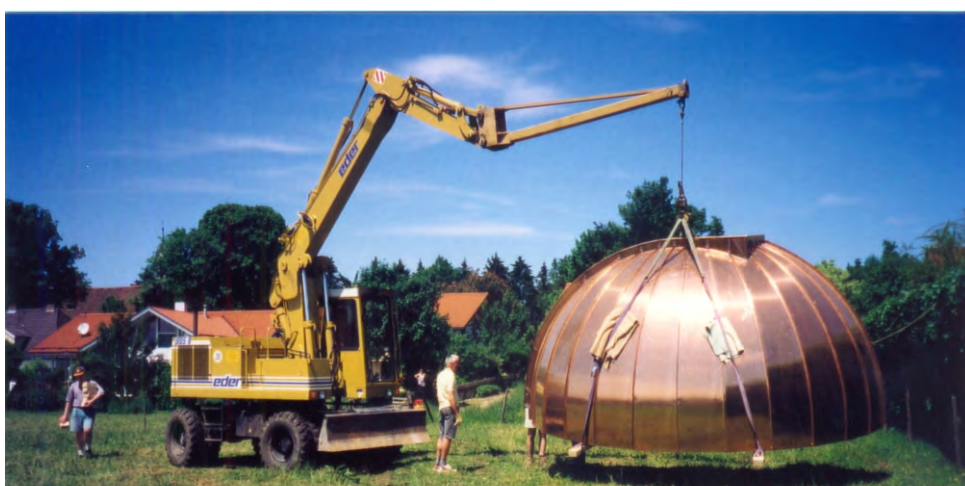
Transport einer Kuppelhälfte zum Aufstellungsort durch Helmut Biller
